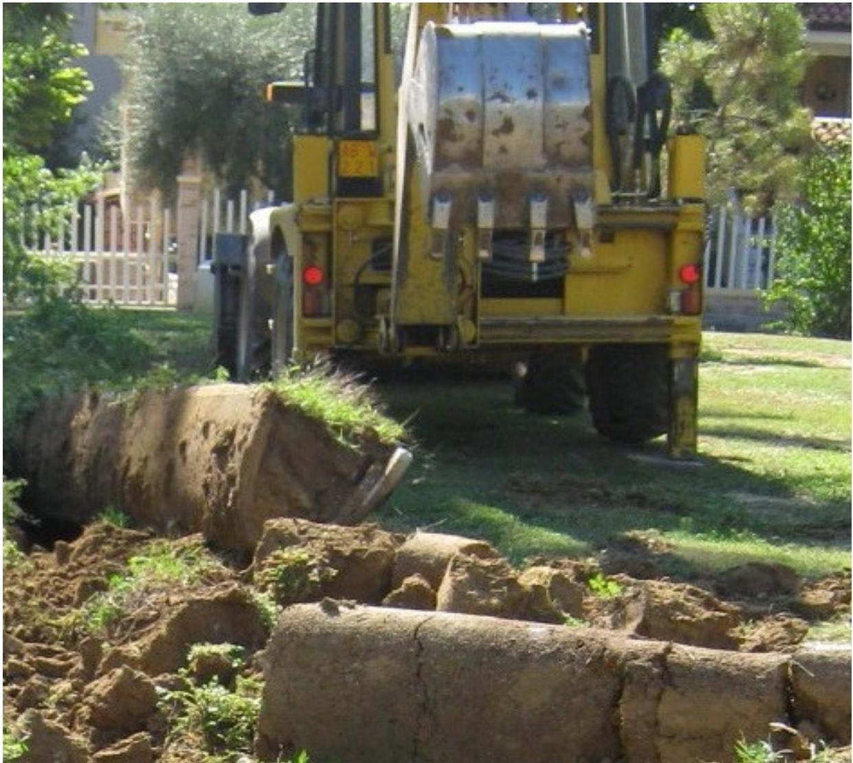
foto n. 1 - inizio scavo rimozione manufatti e detriti in calcestruzzo interrati e/o seminterrati presenti nell'area dello stagno - data 01/10/2010
